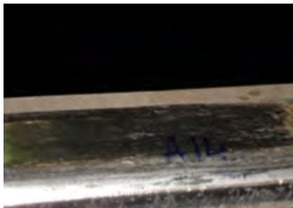
Состояние подкранового пути через четыре месяца ПОСЛЕ установки систем смазки (выравнивание поверхности, отсутствие задиrow)
