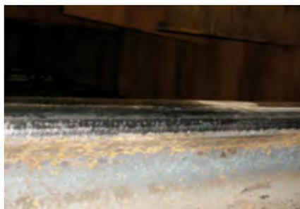
Состояние подкранового пути ДО установки систем смазки (задиры, коррозия)
